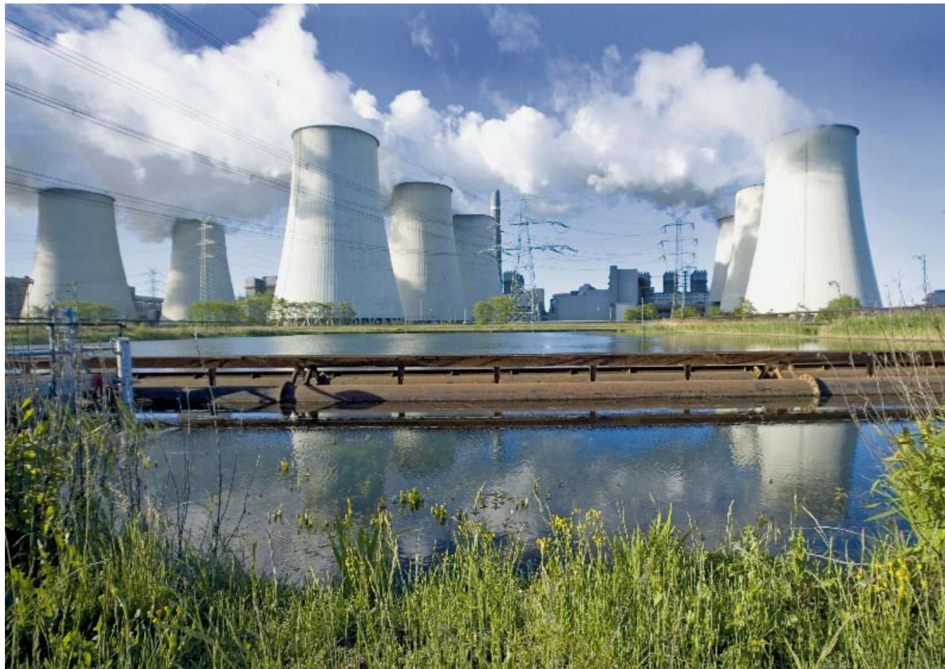
Kraftwerk Jämschwalde: Retrofit der Antriebe erhöhte die Zuverlässigkeit der Kohlezufuhr.
