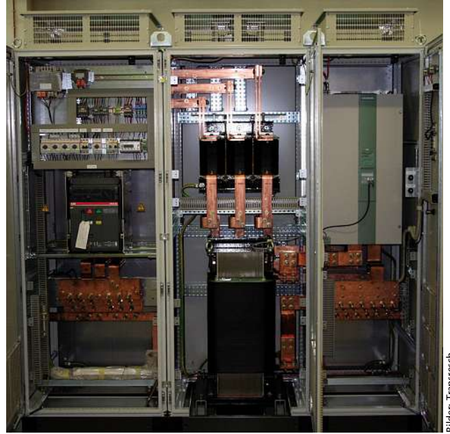
Bild 3: Bei den Gleichstromantrieben ist es wichtig, die alte, meist analoge Informationselektronik durch eine digitale Server-Lösung zu ersetzen.
