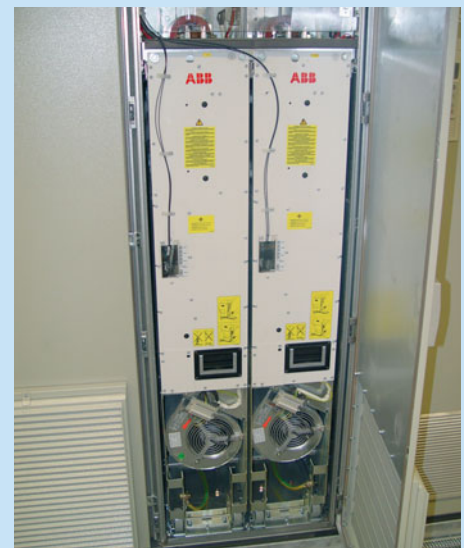
ACS800: Netzurückspeisung und Dämpfung von Oberschwingungen bringen Vorteile für Betreiber
